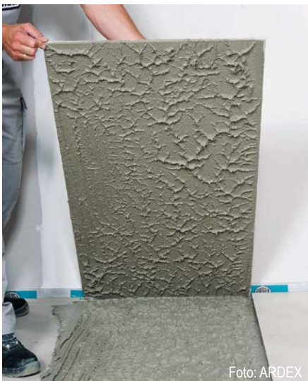
Verlegung am Boden ohne Hohlraumbildung
