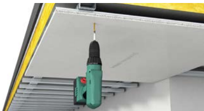
Fermacell Powerpanel H 2 O mit Powerpanel Schrauben direkt in geeigneter korrosionsgeschützter Metallunterkonstruktion befestigen. Bei Holzunterkonstruktionen ist die Befestigung mittels zugelassener Klammern möglich.
