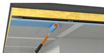
Nach einer Trocknungszeit von ca. 24 Stunden werden die Fermacell Powerpanel H 2 O Platten inkl. der Plattenkanten vollflächig mit Fermacell Tiefengrund grundiert.
