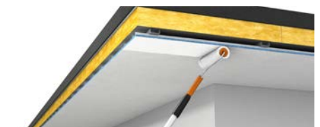
Abschließend nochmals nass in nass mit der Silikat-Fassadenfarbe beschichten.
